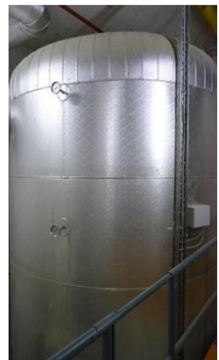
Fassadendämmung mit Steinwolle 20cm, Dach und Boden mit Foarmglas 40 cm
