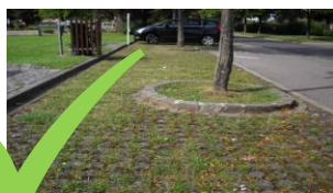
Abb. 3 Befestigte Flächen müssen nicht versiegelt sein. Eine bewusstere Auswahl von wasser-durchlässigen Baumaterialien ermöglicht je nach Nutzungsanforderung eine „natürlichere“ Gestaltung.
