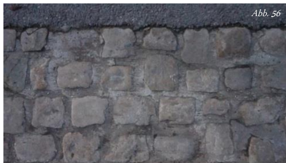
Neu ausgefugte Pflastersteine mit Beton; etwa 1 Jahr alt
