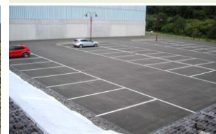
Abb. 10 Bautechnische Kriterien und Normen werden bei der Planung mit höchster Priorität behandelt. Dabei geraten ästhetische Aspekte meist ins Hintertreffen. Möglichkeiten zur Begrünung werden oft lediglich als „Lückenfüller“ erst bei der Ausführung von Bauprojekten thematisiert.
