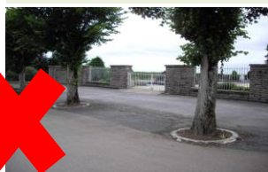
Abb. 7 Versiegelten Flächen wird nachgesagt, dass sich der Aufwand für deren Unterhalt auf ein Minimum reduziert. Häufig geht diese Praxis jedoch auf Kosten der Ästhetik und der Umwelt und ist mit einem hohen Aufwand verbunden, um das Ableiten von Niederschlägen zu gewährleisten.
