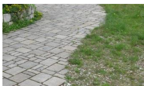
Abb. 5 Fließende Übergänge erhöhen nicht nur den Nutzerkomfort, sie schaffen Raum für kontrollierten Pflanzenwuchs, lassen Niederschlag vor Ort im Boden versickern, und reduzieren den Pflegeaufwand,
